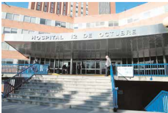
Puerta Principal del Hospital 12 de Octubre.
